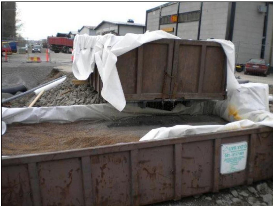
Kuva 11. Esimerkkikuva vaihtolavan sisään rakennetusta suodattimesta. 2
