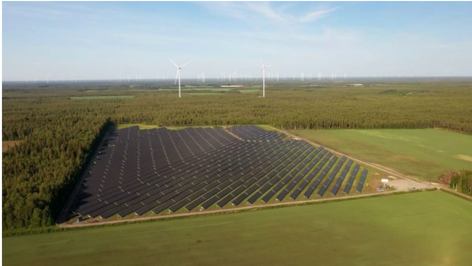
Kuva 11. Kalajoen Juurakon aurinkovoimala. (Solarigo Systems Oy, 2023)
